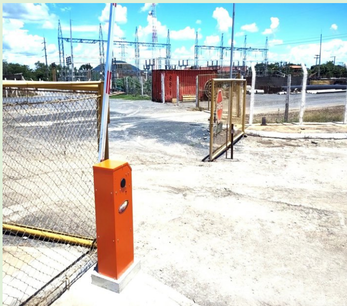
Manutenção de cercas e instalação de cancela de controle de acesso - Estação EB-1
