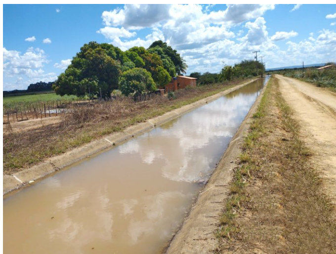
Roçagem Canal CS-12/B - Gleba B
