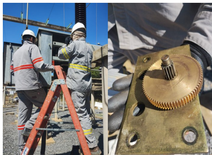
Substituição engrenagem do disjuntor 138 kV da Subestação EB-2
