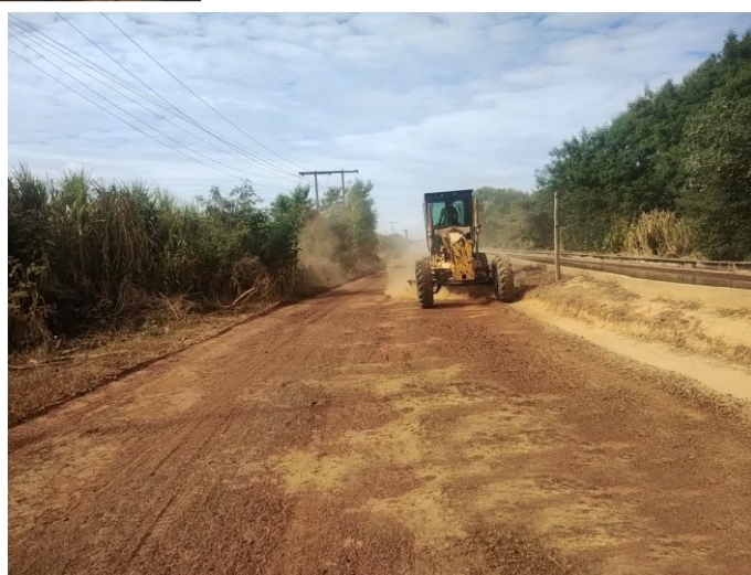
Estrada Canal CS-3F Gleba F
