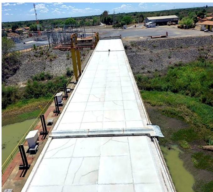
Impermeabilização da Laje - Estação EB-1
