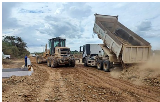
Ponte de concreto e alargamento de passagem em estrada da Gleba F
