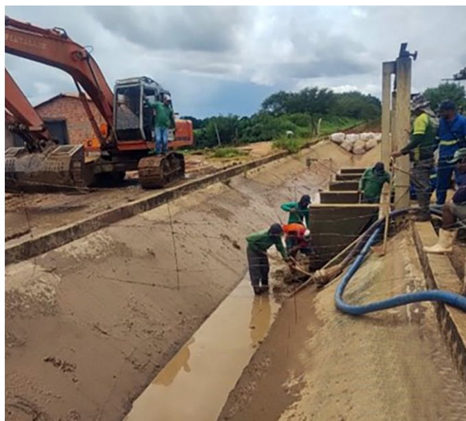
Limpeza da bacia e câmaras de captação da EB-3F
