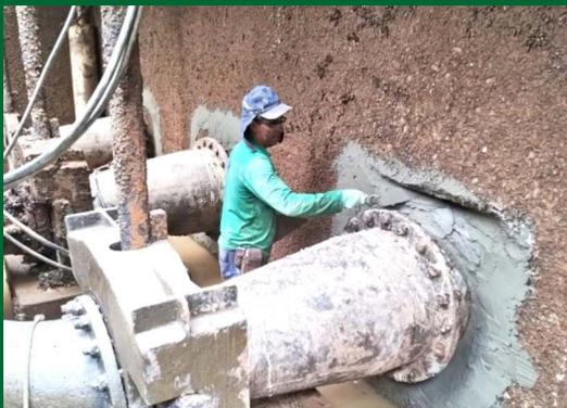
Recuperação das paredes do poço sucção da estação ER-CP/C2
