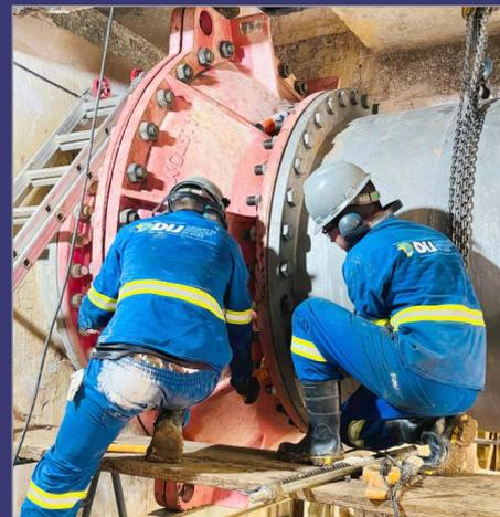
**Substituição do obturador e mola de válvula de retenção DN 1500**
