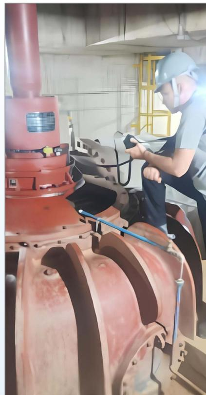
*Manutenção preditiva nos conjuntos motobombas da Estação de Bombeamento 1*
