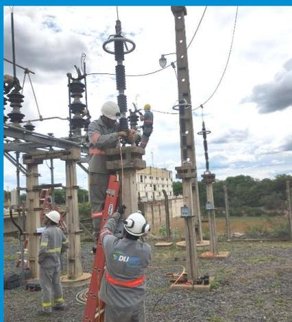
Instalação de novos para-raios na linha de entrada da subestação da Estação de Bombeamento 1
