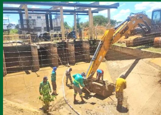
Assoreamento sendo retirado da bacia de captação da estação ER-CP/A4
