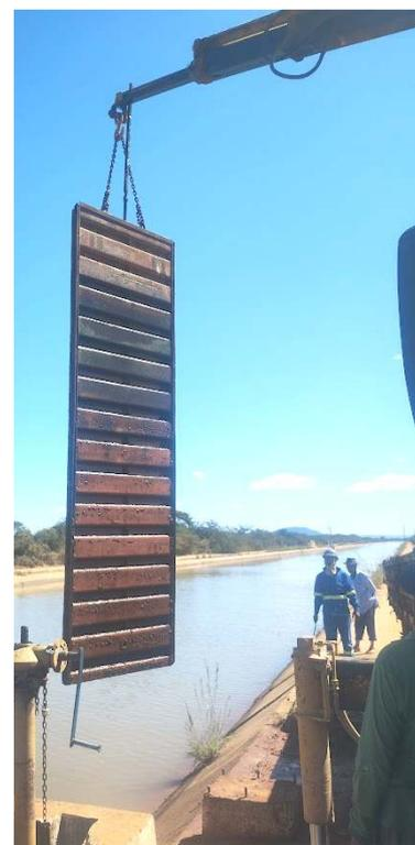
**Fabricação e instalação de comporta de controle de vazão no canal CP/A2 da Gleba A e manutenção corretiva da comporta de controle de vazão do canal CS-1F da Gleba F**
