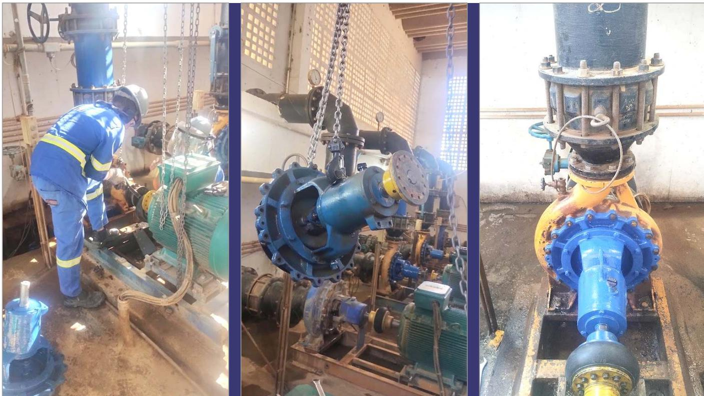
**Manutenção corretiva nas bombas centrífugas de eixo horizontal dos conjuntos motobombas da Área F**
