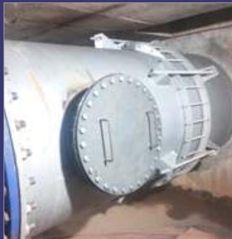
**Aquisição e instalação de bocas de visita na tubulação DN 1500 de condução de água da EB-2**
