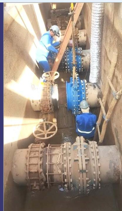
*Manutenção corretiva para substituição de válvulas de retenção da tubulação dos conjuntos motobomba da Estação de Recalque ER-CP/C2*
