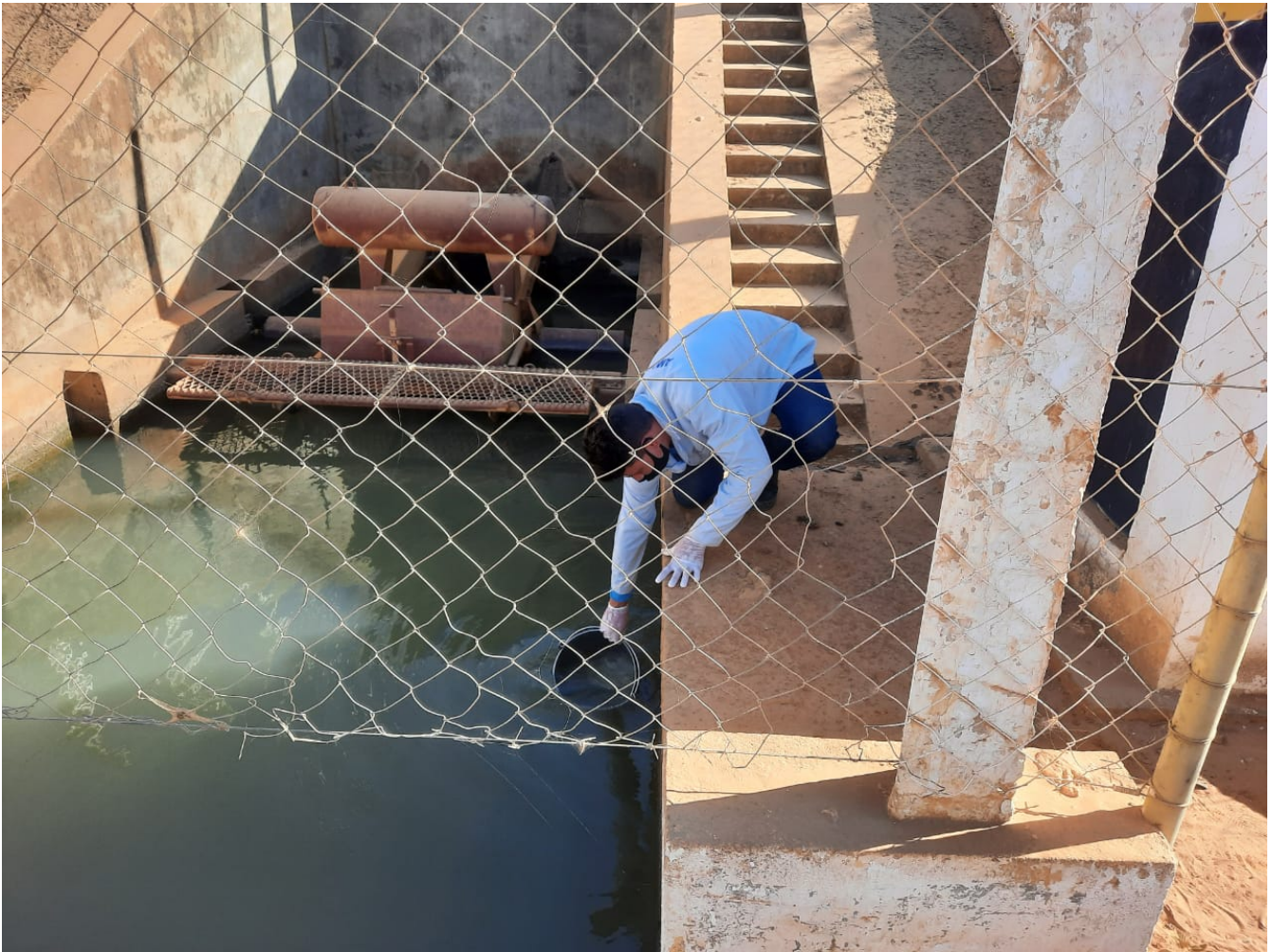
Dreno Jaíba a Montante da Travessia do Sifão que alimenta a Gleba C2
