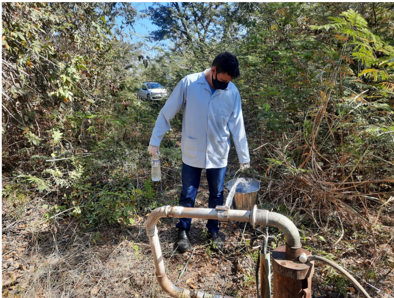
No poço profundo do Núcleo de Serviço NS-4/B, Gleba B
