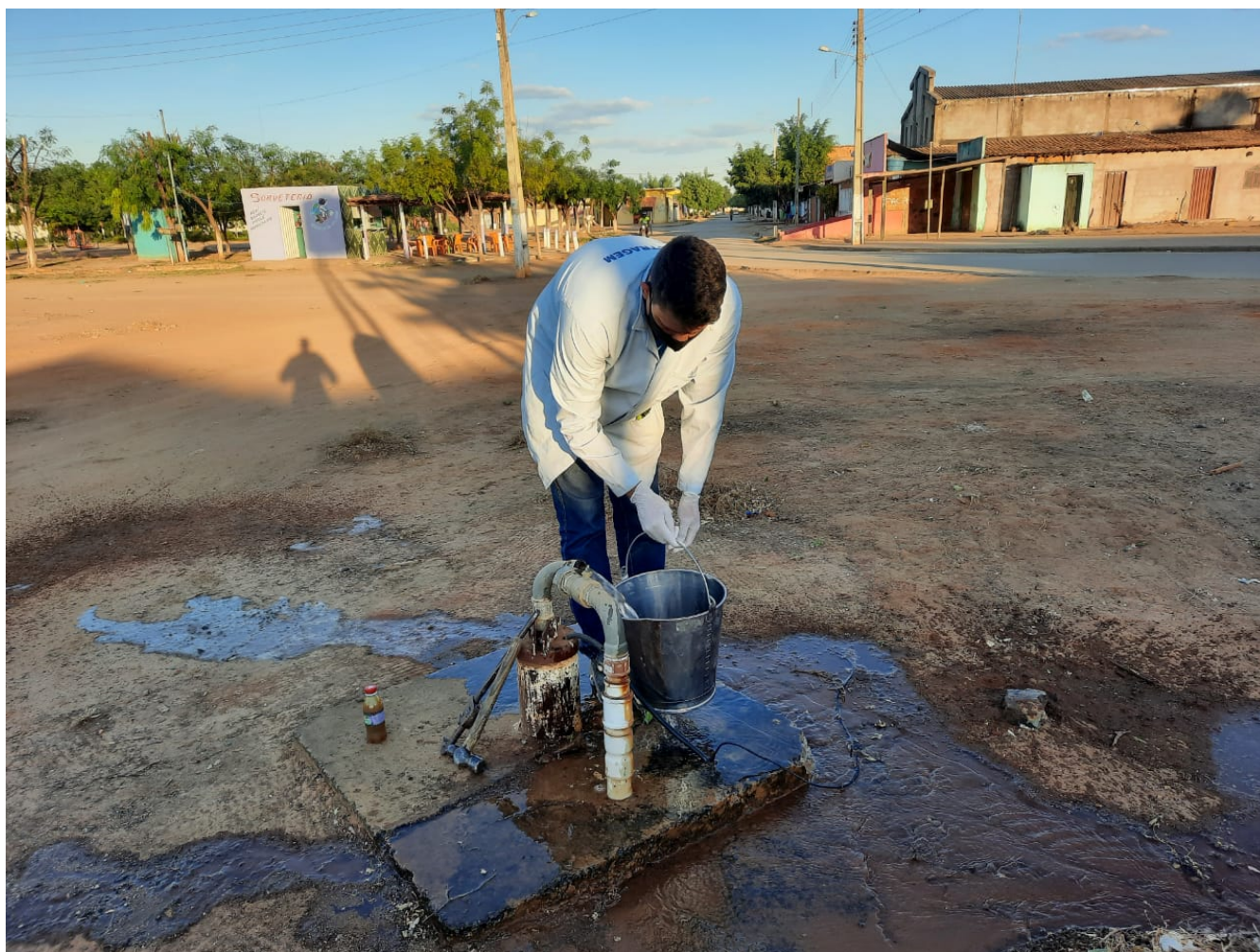
No poço profundo Núcleo Habitacional NH-2, Gleba F
