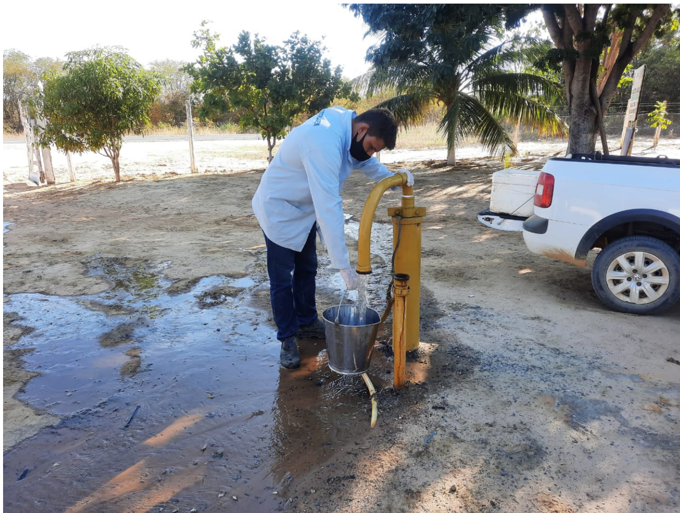
No poço profundo localizado casa 1 da Reserva Legal
