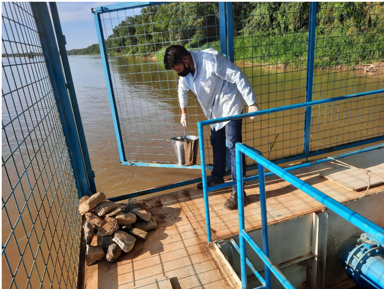
Jusante do Perímetro captação da Fazenda Yamada
