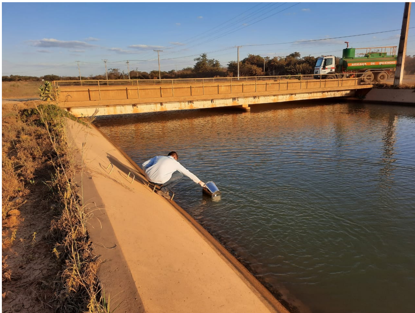
No canal CP-2 próximo à elevatória EB-3
