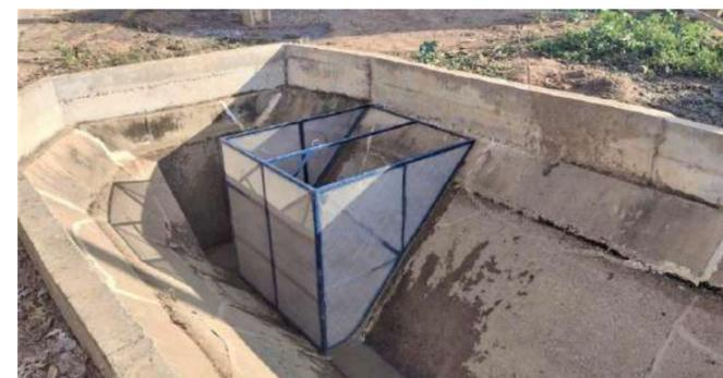
Instalação de tela na captação final de canal
