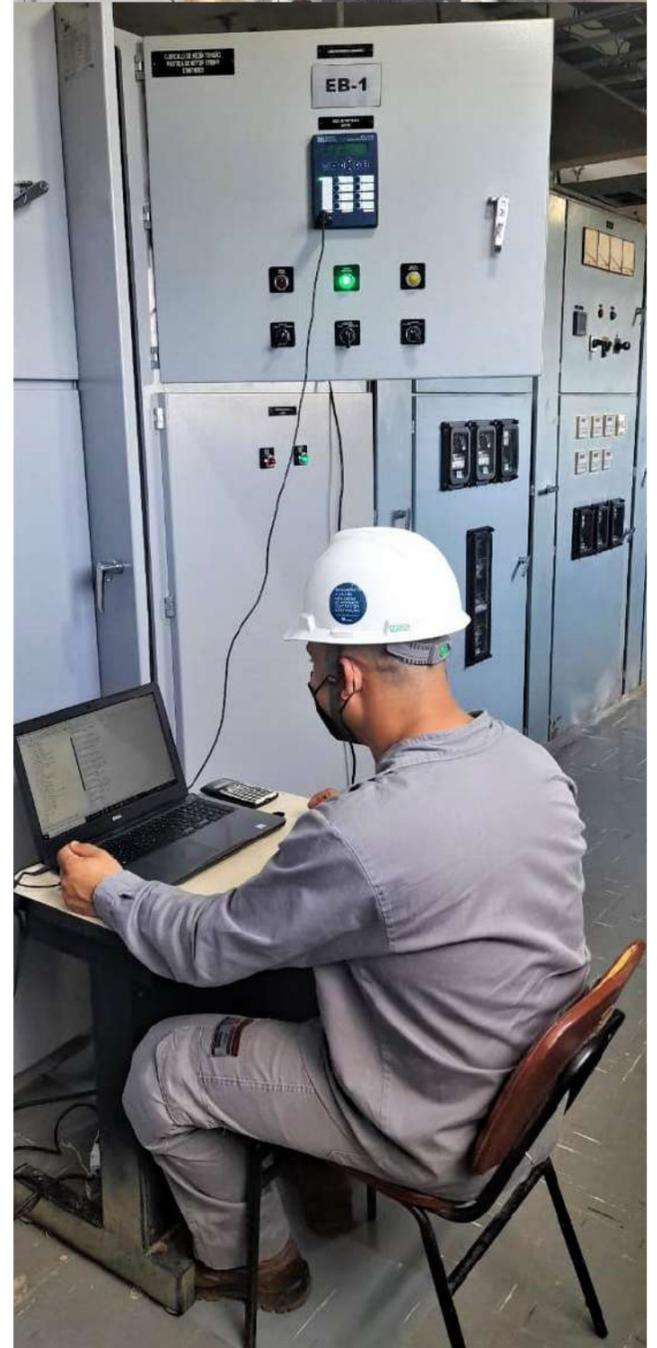
Calibração dos relés de proteção nos painéis elétricos motores da EB-1
