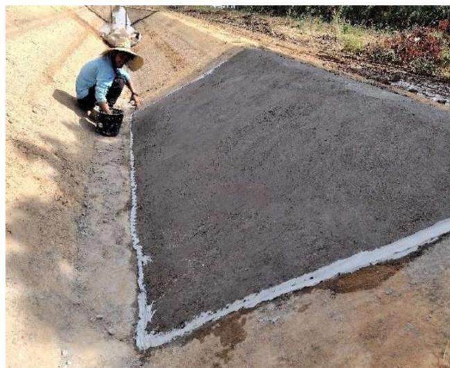
*Recuperação de juntas e substituição de placas em canais de irrigação*
