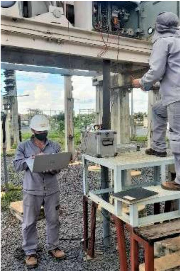
Testes elétricos nos Disjuntores de 138kv na Subestação EB-1
