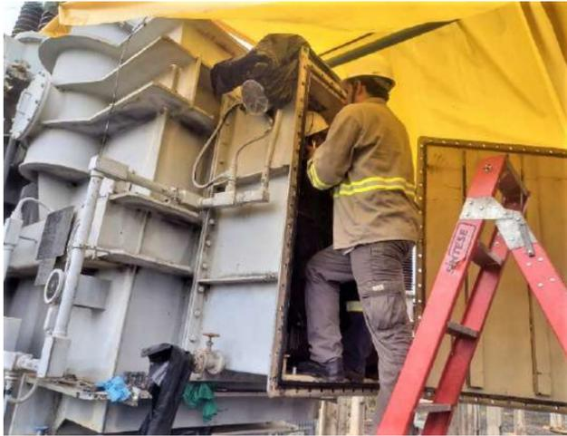
Troca de óleo comutador do transformador da EB-1
