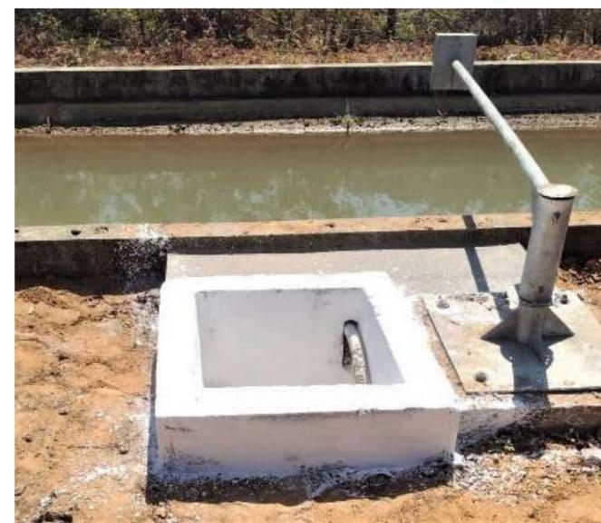
Instalação de novas tubulações e sensores de nível na ER/C3
